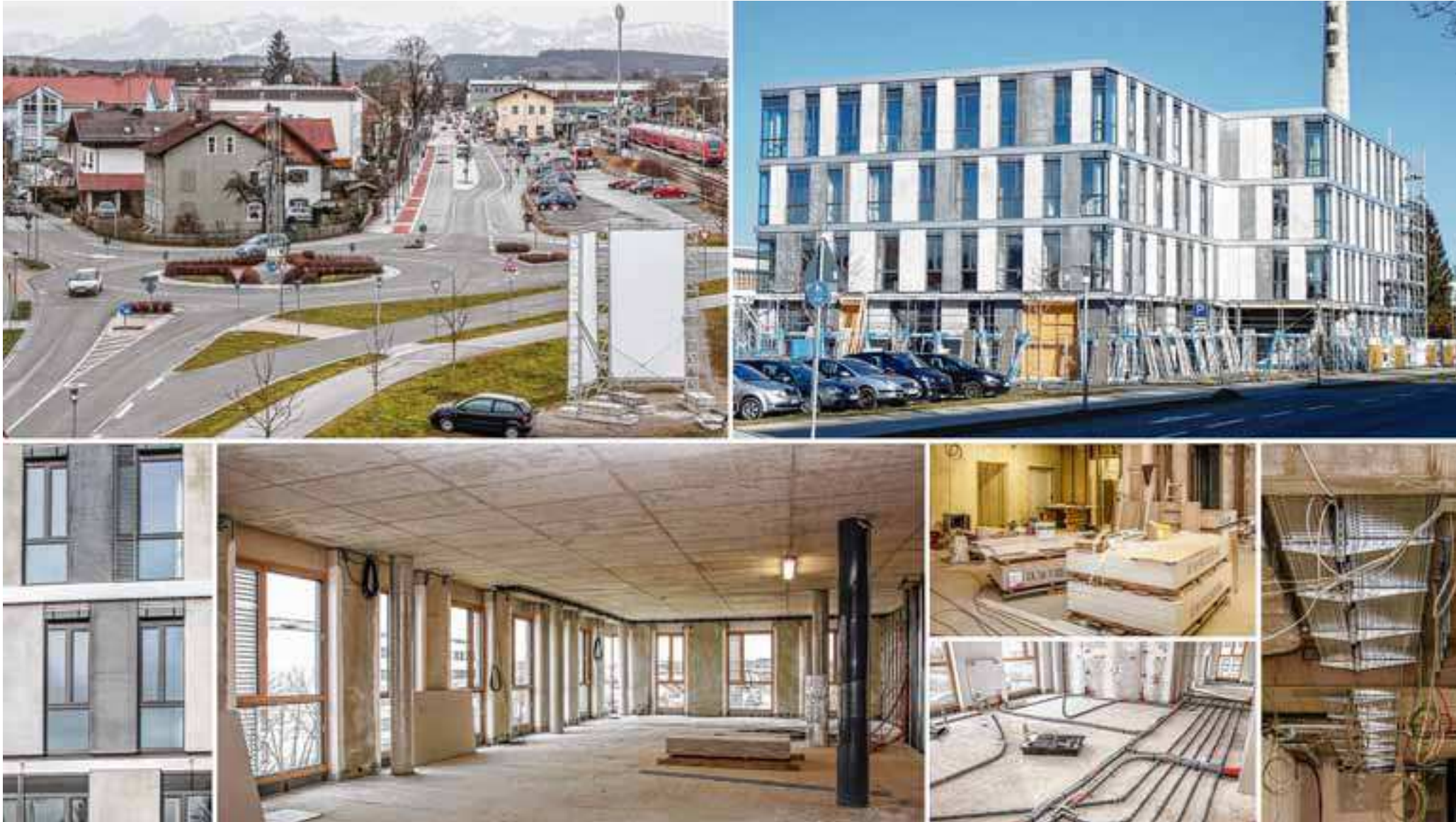
Alles im Zeitplan beim Bau des Ärztehauses „Medicum“: Innen sind derzeit die Elektriker, Heizungs- und Lüftungsbauer zu Gange (Fotos unten). Das Gerüst an der Außenfassade ist mittlerweile abgebaut (oben rechts und unten links). Aus dem obersten Stock geht der Blick über die Stadt in Richtung Berge (oben links).
