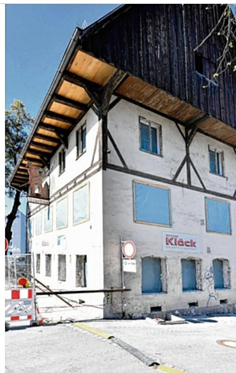
Das als ehemaliger Stachus bekannte Gebäude in der Gutenbergstraße zeigt sich derzeit als Baustelle. Foto: Langer
